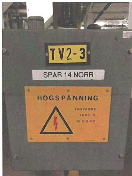
Bild 3: TågvärmegetPost typ AST 03 placerad i källaren
