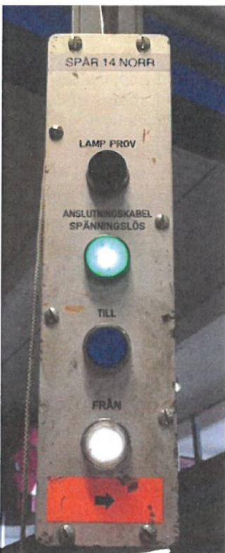
Bild 1: Manöverställare för tågvärmepost typ AST 03 i nya vagnhallen. Manöverställaren hänger i takramp ovan plattform i respektive spårs ände.
