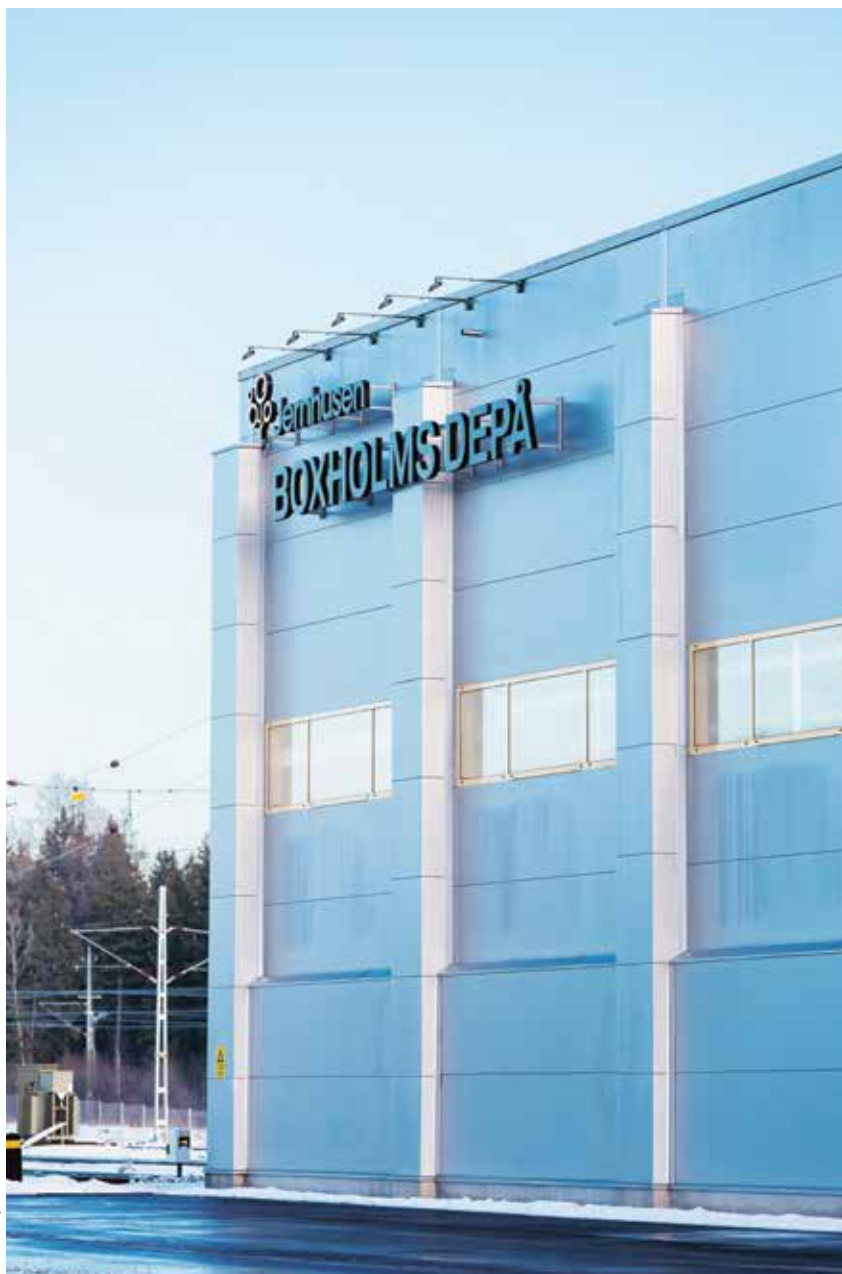
Boxholms Depå är Jernhusens nyaste underhållsdepå och den invigdes 2013.
