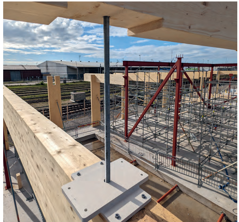
Trästommen är monterad av KL Projekt AB. Foto: KL Projekt AB
