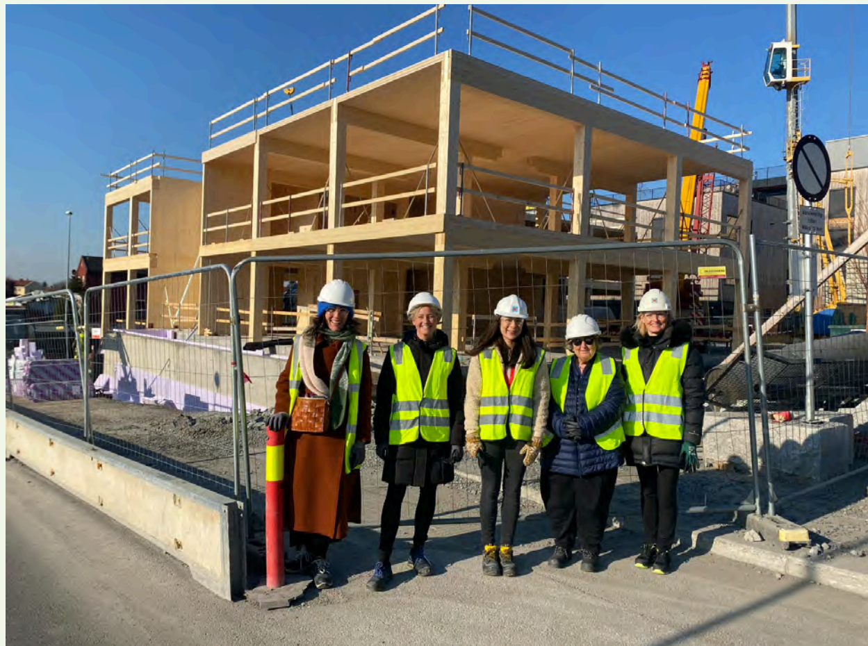
Redd Barna skal flytte inn HasleTre som er under bygging. Ferdig i Q4 2022.
