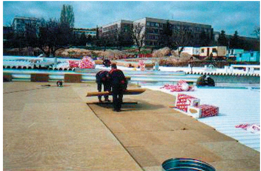
супермаркет БИЛА, Стара Загора - Покривна топлоизолация с Rockwool Dachrock
