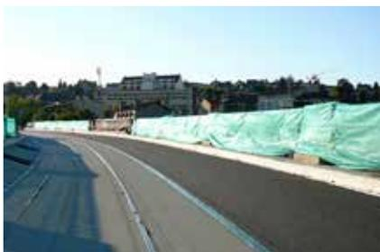
Système composé d'une membrane en bitume élastomère SBS d'épaisseur 4 mm, soudée en plein sur le support (Parafor Ponts), et d'une protection par géotextile anti-poinçonnant de 2 000 g/m<sup>2</sup> permettant la pose directe du ballast sur le système.
