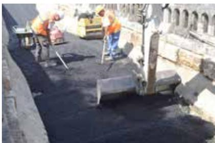
Béton bitumineux à mise en œuvre à froid, Refax Rail s'utilise principalement pour les ouvrages en réfection du type ponts-rails à pose de voie ballastée et traverses supérieures ballastées en extrados de tranchée couverte. Il permet le reprofilage du support d'étanchéité ainsi que la protection de l'étanchéité en feuille bitumineuse Parafor Ponts contre l'action du ballast. Il peut également être utilisé en travaux neufs.
