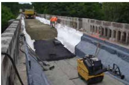
Paracoating Deck est une étanchéité mono-composante à base de MS Polymer pouvant être raccordée sans primaire d'accrochage à une membrane d'étanchéité de partie courante de la gamme Siplast. Le Paracoating Deck s'applique en deux couches.
