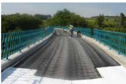
Système mis en œuvre en indépendance composé d'une géomembrane en bitume élastomère SBS d'épaisseur 4 mm, armée d'un tissu de polyester (Teranap 431 TP), posée entre deux feutres géotextiles anti-poinçonnant (700 g/m<sup>2</sup> sous la membrane, 2 000 g/m<sup>2</sup> sur la membrane) et pouvant recevoir directement le ballast.
