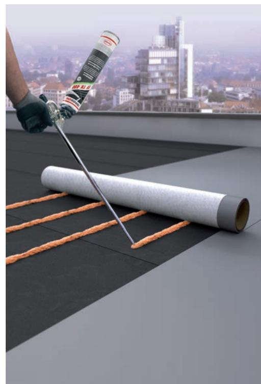
La mise en œuvre de **Monarplan GF** s'effectue par collage. Il suffit de déposer les cordons de colle sur le support propre et dépoussiéré, puis de maroufler la membrane. À noter que grâce au pistolet à colle, la pose se fait sans s'agenouiller ce qui réduit grandement la pénibilité sur chantier. Les jonctions longitudinales se réalisent par soudure à air chaud. Les jonctions transversales sont pontées à l'aide de la bande Monarplan.
