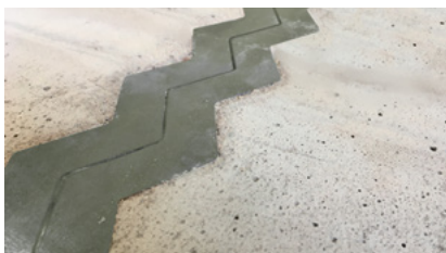
Fuge nach dem Betonieren
