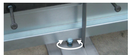
Höhenjustierung durch Stellschraube
