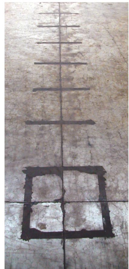
Sanierung eines Fugenschnittes durch nachträgliche Verdichtung
