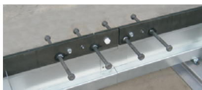
Stoßverbindung durch Kunststoffschraube
