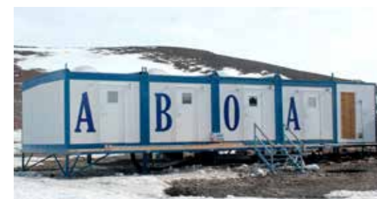
Tutkimusaseman uudet asuinkontit asennettuina. New accommodation and research containers of Aboa station.
