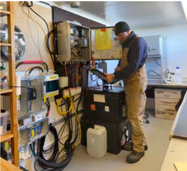
Priit Tisler huoltamassa tutkimusaseman automaattista sääasemaa.
