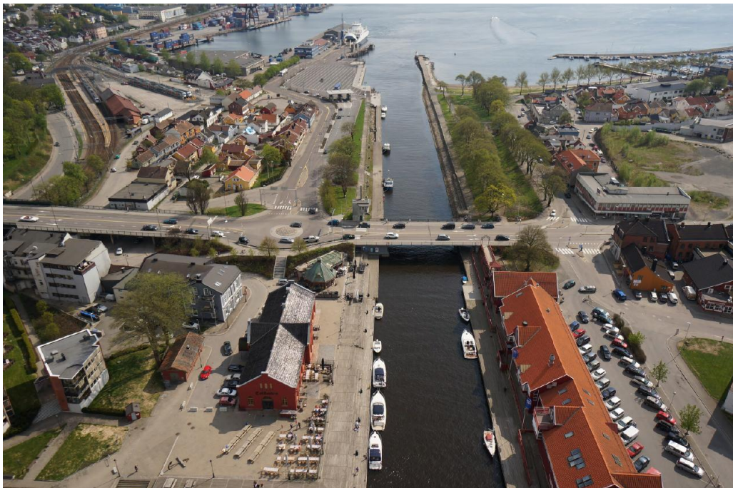
Helikopterflyfoto, T. Eriksen – Moss Havn og Moss by Jærløysbroa, sett fra nord
