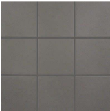
Pesuhuone /khh, lattialaatta
