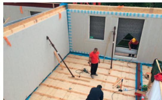
Aufstellen der vorgefertigten Holztafelbauwände
