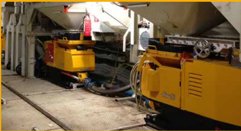
Perlkieshinterfüllanlage auf einer Tunnelbohrmaschine
