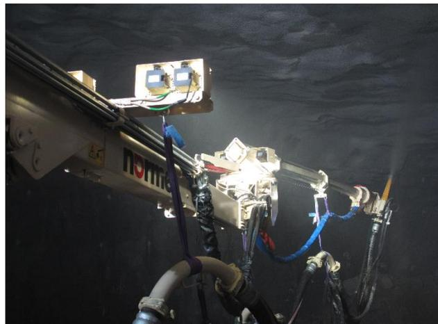
TamShot 110AF は吹付けコンクリート用途を目的とした高性能液体急結剤です。TamShot 110AF は鉱山やトンネル現場における湿式吹付けコンクリート施工において使用されます。この製品は地盤の初期補強が必要な現場や、シングルシェル構造トンネルの様な耐久性が求められる吹付け用途に対して適用されます。
