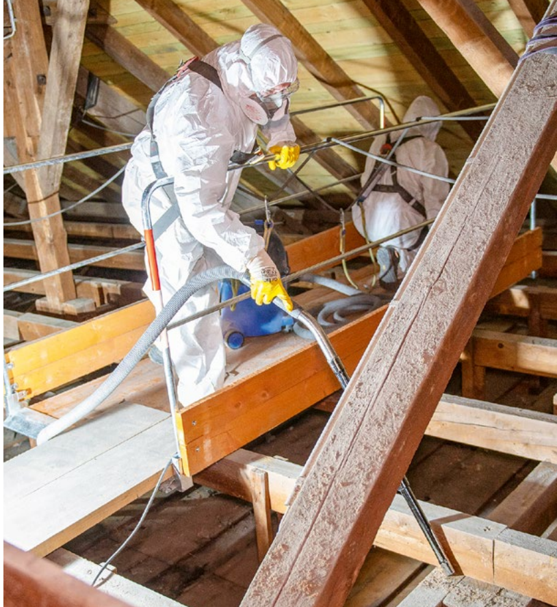
Beschäftigte, die besonders gefährliche Tätigkeiten wie die Asbestsanierung ausüben, unterliegen einer Pflichtvorsorge.
