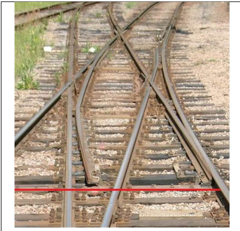
Fig. 13. Stoppgränser vid enkel korsningsväxel
