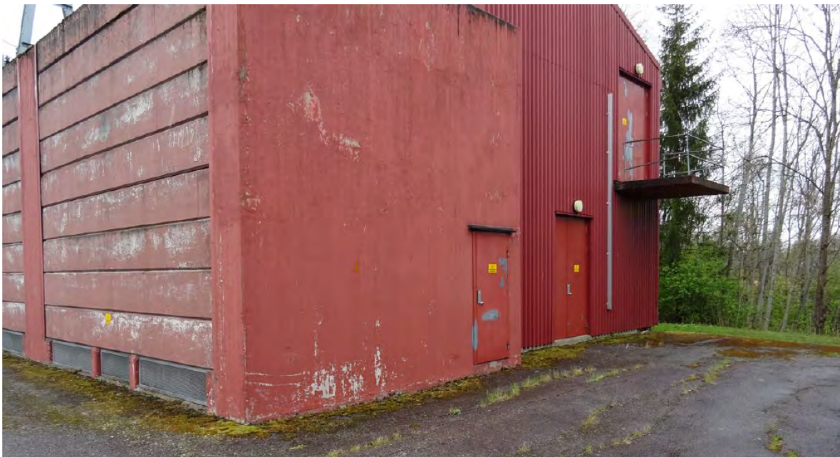
Figur 12: Garder transformatorstasjon. Ny spole plasseres inntil veggen på høyre side.
