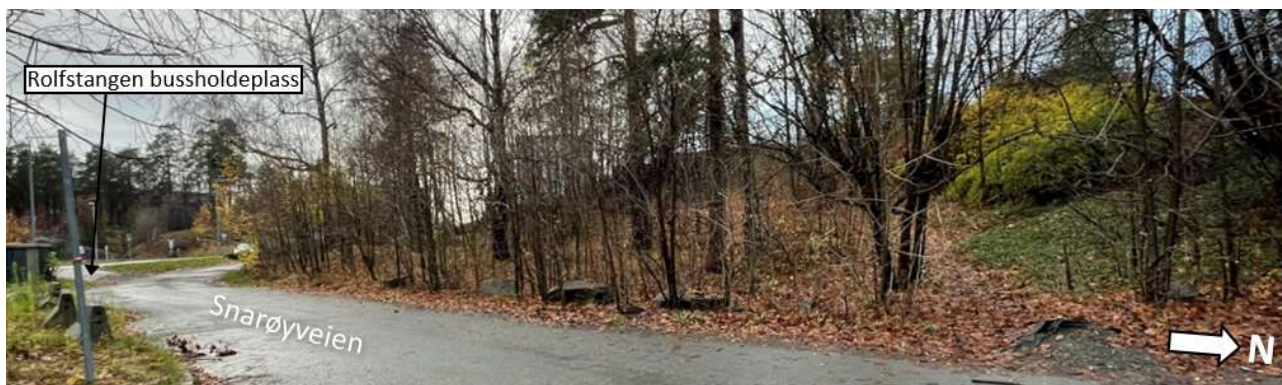
Figur 3: Sørvestre delen av tiltaksområdet. Her er det planlagt at transformatorstasjonens stasjonsbygg skal bygges
