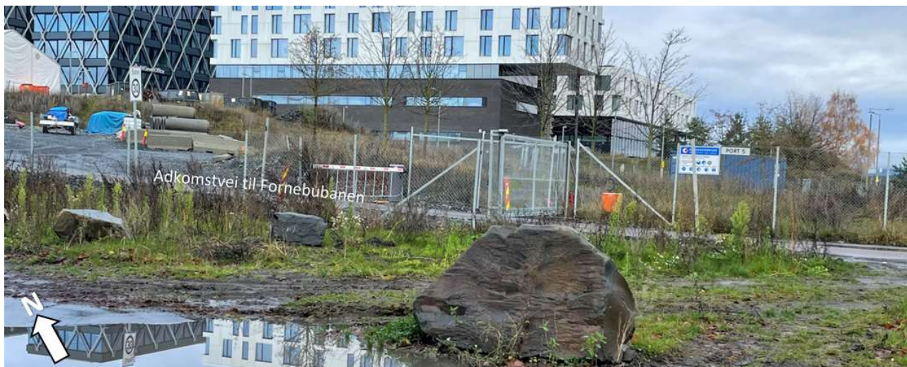
Figur 4: Nordøstre delen av tiltaksområdet. Her er det planlagt at trafobygget skal bygges, se også Figur 5
