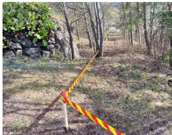
Figur 2-5 og 2-4. Markering og innmåling av anleggsgjerde. Vinkelpunktet til anleggsgjerdet er plassert i stien og langs med fjellskrenten (nedenfor, ikke oppå - se vedlegg 1) for å minimere påvirkning.
