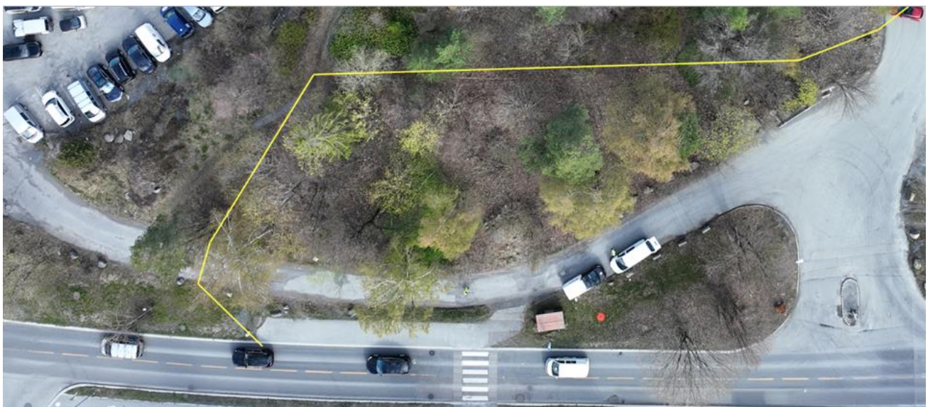
Figur 2-4.c Anleggsgjerde som markerer byggeforbudsgrensen markert med gult.
