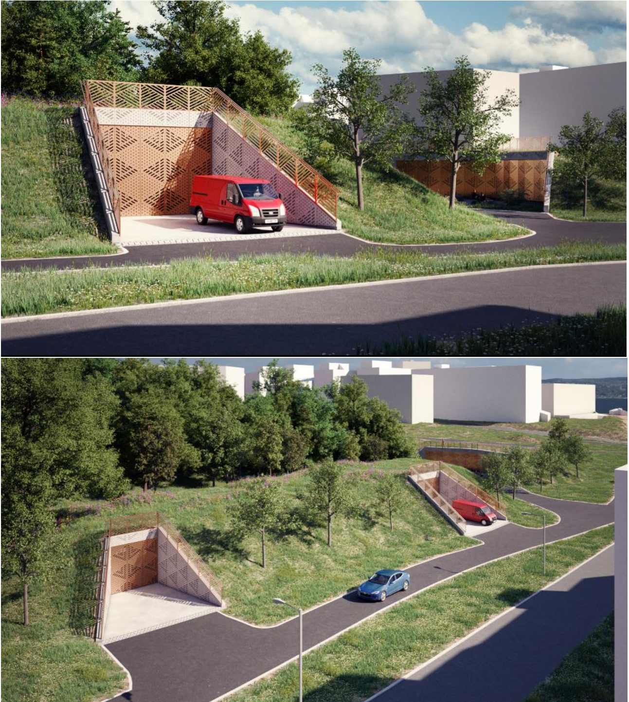
Figur 5-3. Koksa transformatorstasjon ligger nedgravd i terreng
