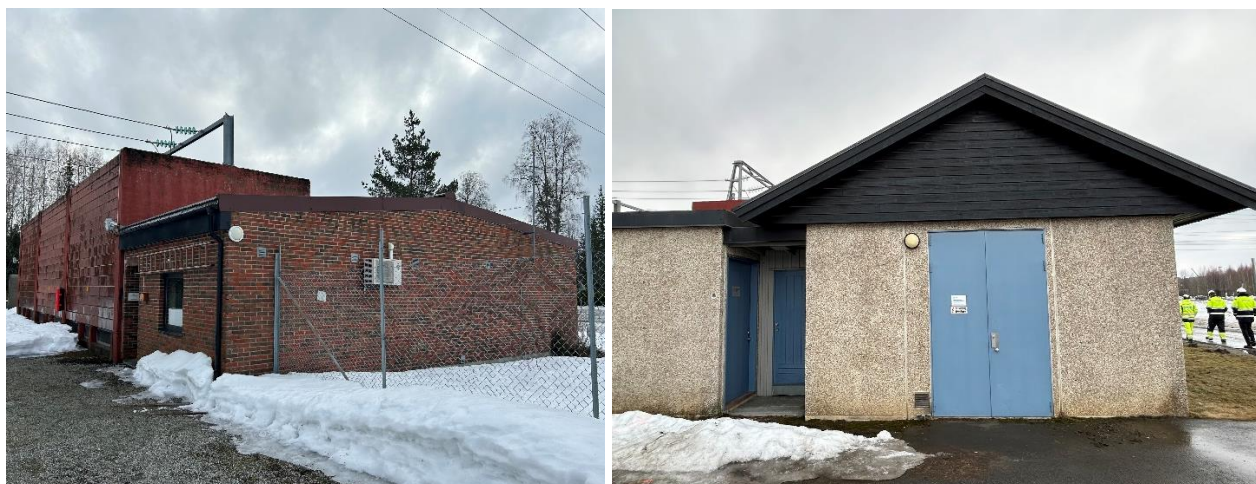
Figur 2: Oversiktsfoto over Dal transformatorstasjon (til venstre) og Gjestad transformatorstasjon (til høyre). (Foto: Rambøll)
