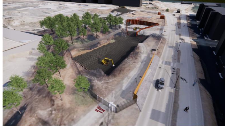
BYGGEGROP SETT FRA VEST
