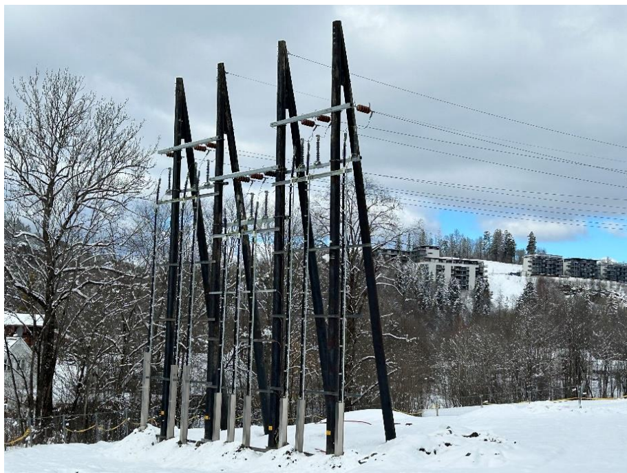
Fig.4, Mast nr. 244115, Midlertidig endemast.
