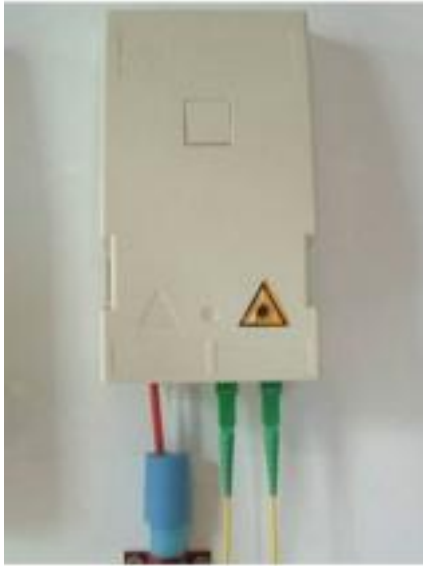
MB4 is uitgevoerd met 2 SC/APC connectoren
