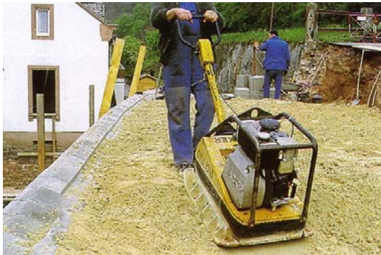
Bild 41: Verdichten über Geogittern
