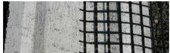
Bild 39: Geogitter auf Böschungsstein
