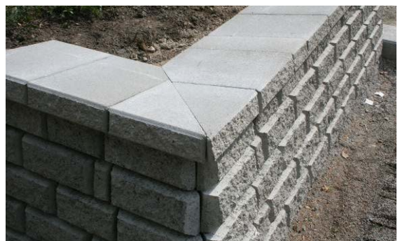
Bild 35: Versetzte Abdeckplatten
