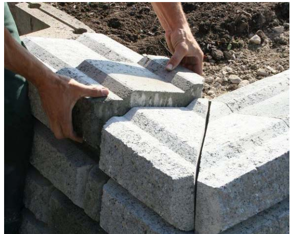
Bild 33: Versetzen der weiteren Steinreihen
