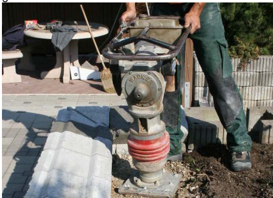
Bild 36: Verdichten der Hinterfüllung
