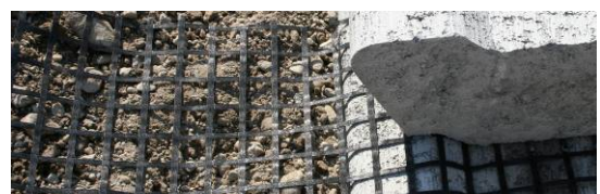
Bild 40: Eingeklemmtes Geogitter
