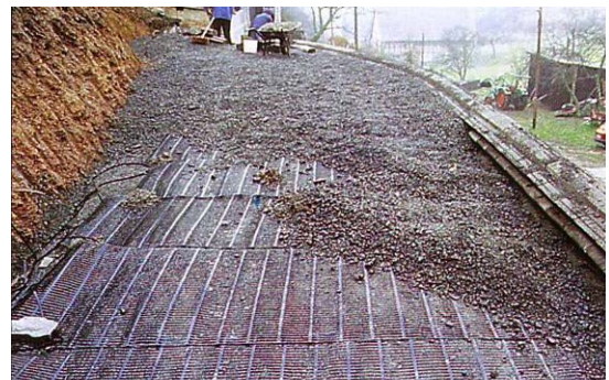
Bild 38: Verlegte Geogitter
