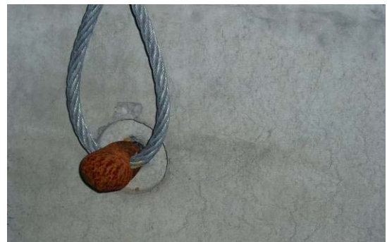
Bild 24: Drahtseilschlaufen M Rd 12 oder M Rd 16
