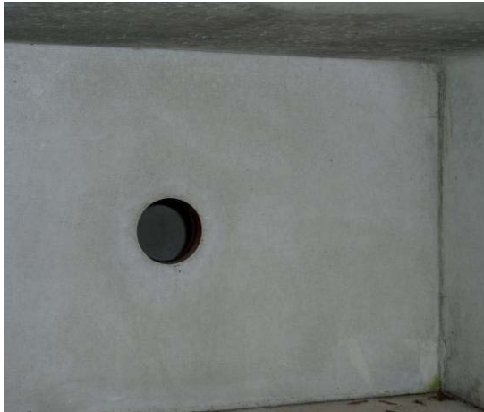
Bild 5: Lichtschacht mit Boden
