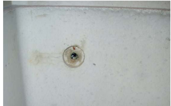
Bild 23: Eingelegte Gewindehülse M 12 oder M 16 für Transport und Montage
