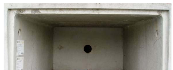
Bild 28: Lichtschachtsohle mit eingebautem Boden
