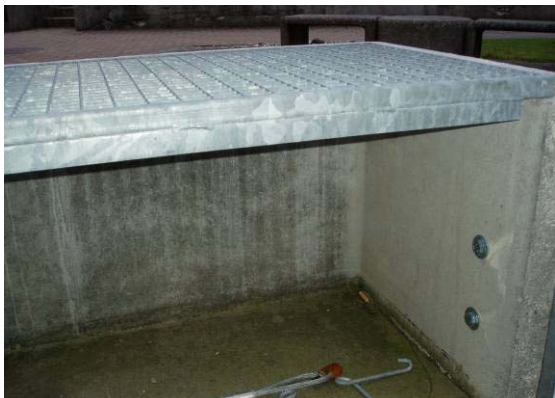
Bild 39: Verstärkte Gitterrostkante gegen die Hauswand
