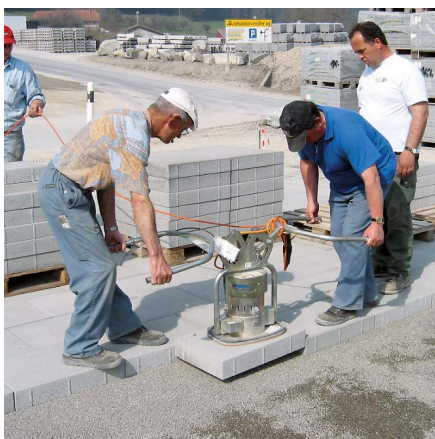
SPEEDY Vakuumversetzgerät bis 120 kg
