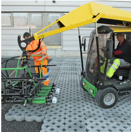
OPTIMAS und PROBST: Maschinelles Verlegen
