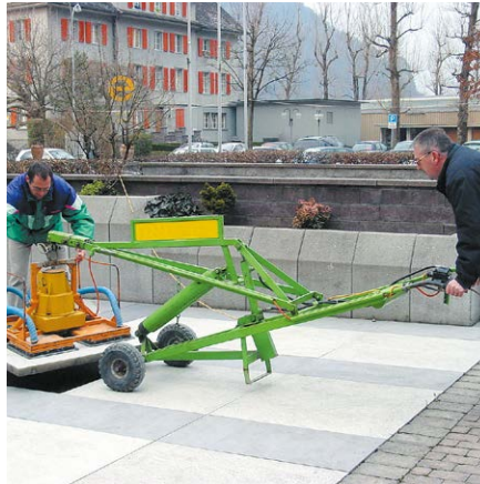
PRESTO Plattenverlegegerät bis 120 kg
