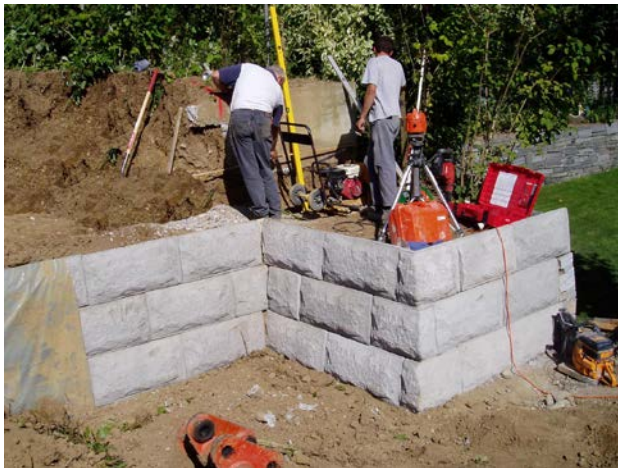
Bild 46: Innenecke mit Gehrungsschnitt und Aussenecke
