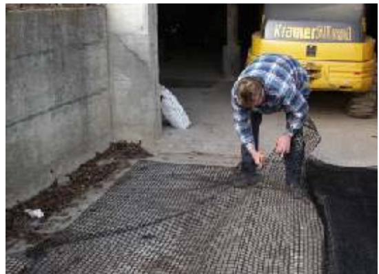
Bild 23: Ablängen der Geogitter
