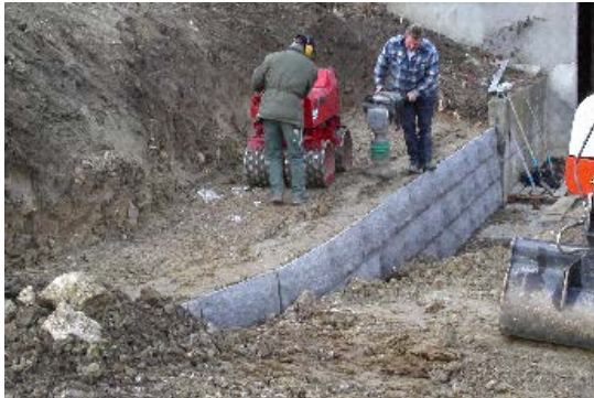
Bild 26: Verdichten der weiteren Schichten
