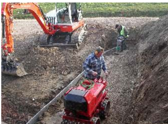
Bild 21: Verdichten mit Schaffusswalze
