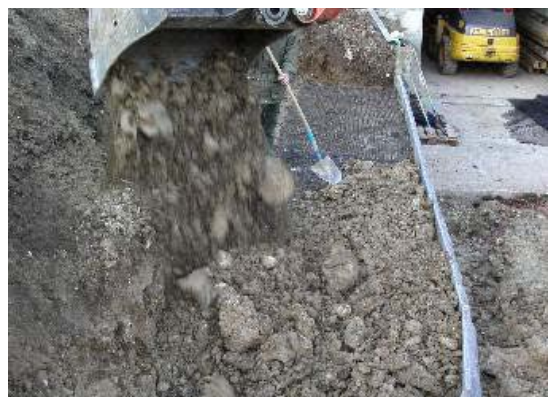
Bild 25: Hinterfüllen der zweiten 20 cm
