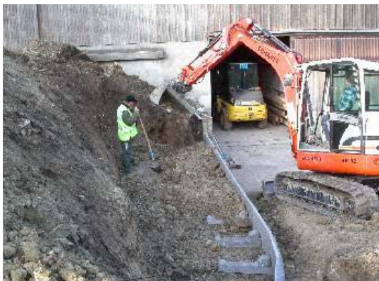
Bild 20: Hinterfüllen der ersten 20 cm
