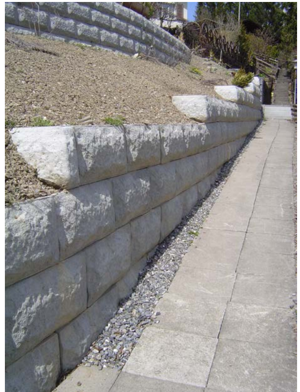
Bild 48: seitlicher Abschluss der Abtreppungen mit Ecksteine
