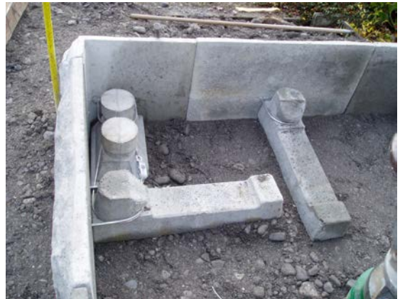
Bild 40: Eckstein mit Eckanker und -spanner
