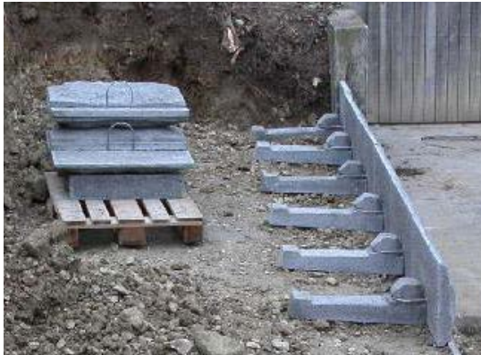
Bild 18: Verlegte Frontplatte mit Normalanker
