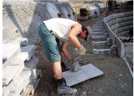
Bild 15: Frontplatte mit Anker verbinden
