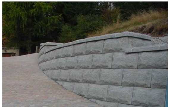
Bild 42: Radius und Abdeckvariante
