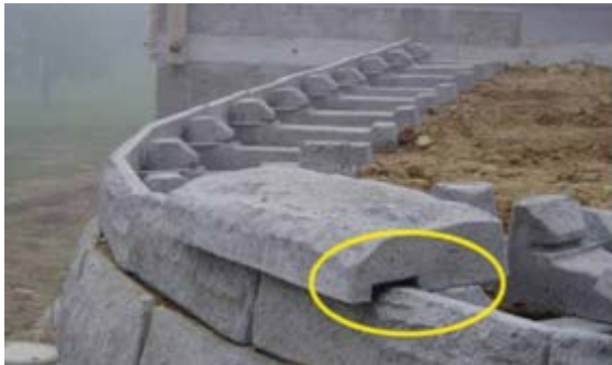
Bild 37: Nicht korrekt versetzte Abdeckplatte auf der Frontplatte 80 x 20 cm
