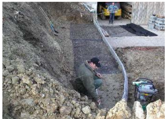
Bild 24: Verlegen der Geogitter, seitliche Überlappung 20 cm
