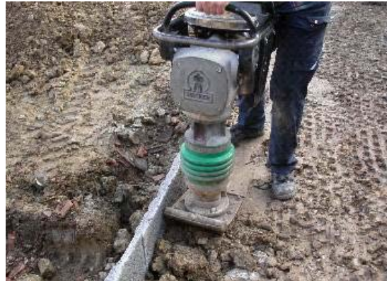
Bild 22: Verdichten mit Vibrostamper
