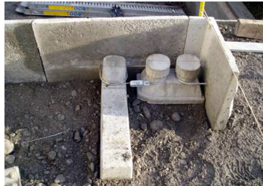
Bild 26a: Eckspanner parallel zum kleineren Schenkel montieren
