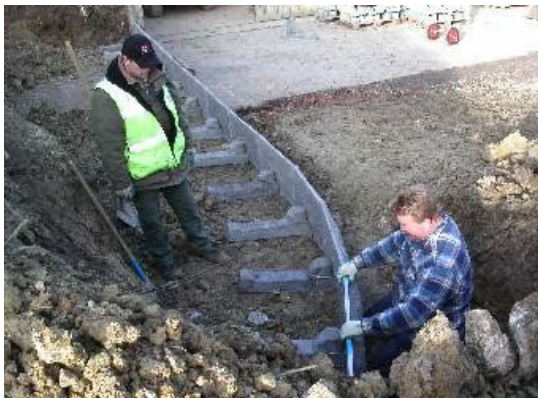
Bild 19: Versetzen der ersten Lage
