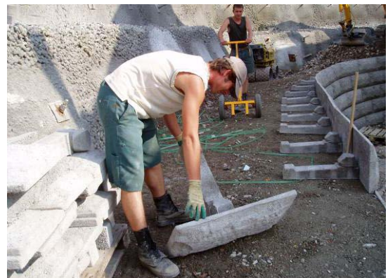
Bild 16: Frontplatte mit Anker verbinden
