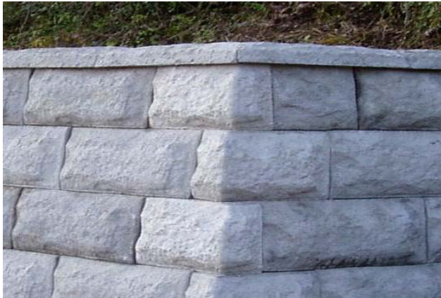
Bild 44: ECKAusbildung mit Abdeckplatte
