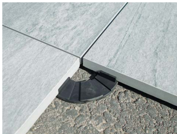
Bild 12: Verlegen der Feinsteinzeug Gehwegplatten auf Lagerringe
