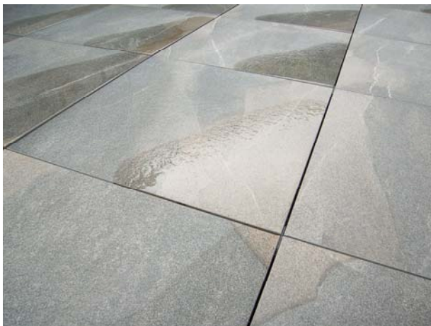
Bild 6: Wasser in Ecken infolge Oberflächenspannung
