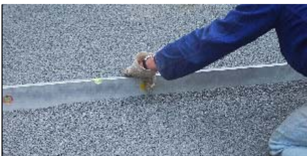
Bild 7: Bettungsschicht abziehen
