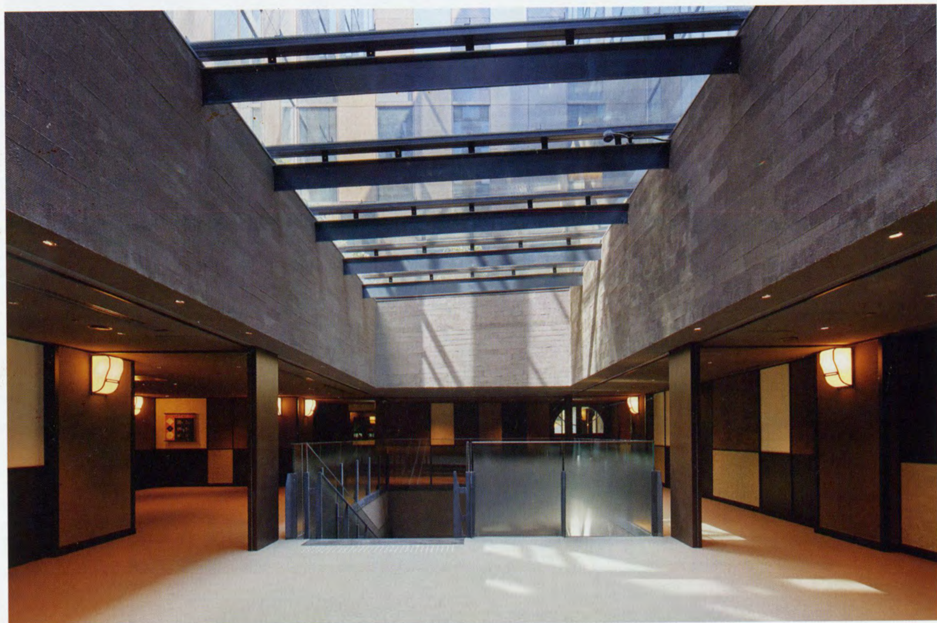
新築棟共用部。階段の天井部に設けられたトップライトは、壁面内側をクシ引き仕上げとし、光を柔らかく室内に落とす
