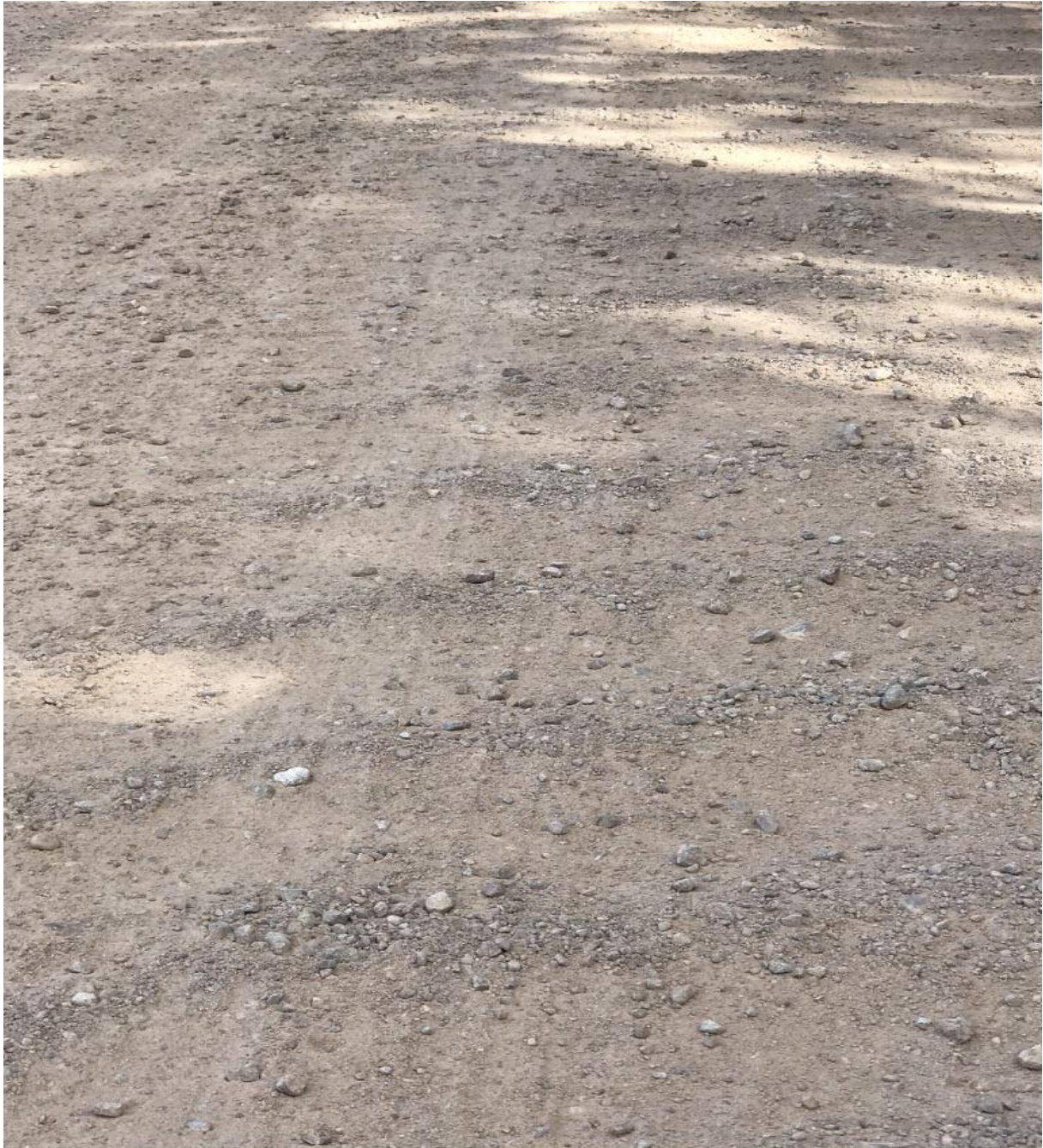
Korrugering samt grovt stenmaterial i ytan
