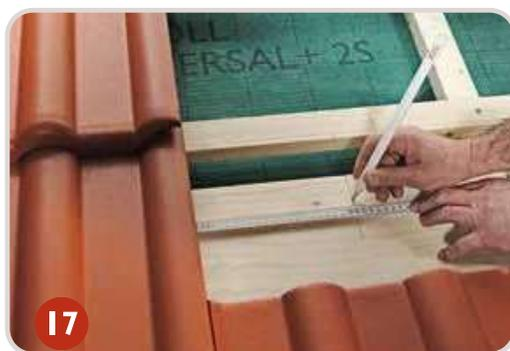
Разстояние до лявата рамка на колектора
