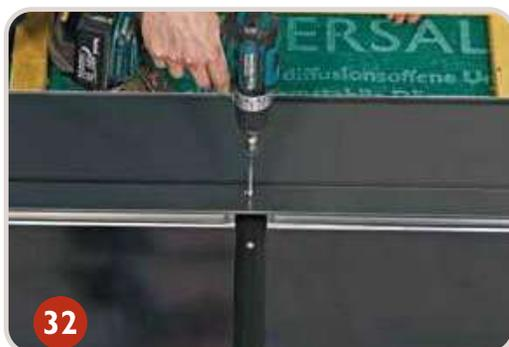
Завийте винтовете към отворите за закрепване на колектора откъм страната на стрехата и билото.
