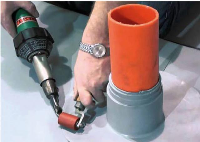
Solde a base da passagem do tubo em torno da sua circunferência até à membrana monocamada colocada abaixo. Comprove a qualidade da soldadura na junta e repare qualquer zona suspeita.
