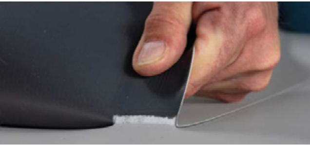
Figura 12. Realização de uma prova de soldadura.
