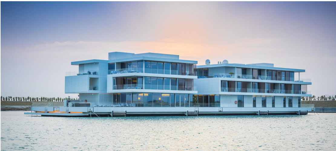
Kuva 13. Maailman suurin kelluva huvila (6000 m 2 ), joka on jälkikäteen varustettu omalla propulsiolla. Myös tämä kohde on suunniteltu ja valmistettu kokonaan Suomessa. Kuvälähde: Meyer Floating Solutions Oy.
