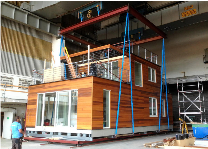
Kuva 23. Ruotsalaisen Aqua Floating Groupin ratkaisussa rakennus tehdään valmiiksi tuotantohallissa, josta se nostetaan suoraan betoniponttonin päälle ja kuljetetaan vesitse kohteeseen. Kuvälähde: Aqua Floating Group.
