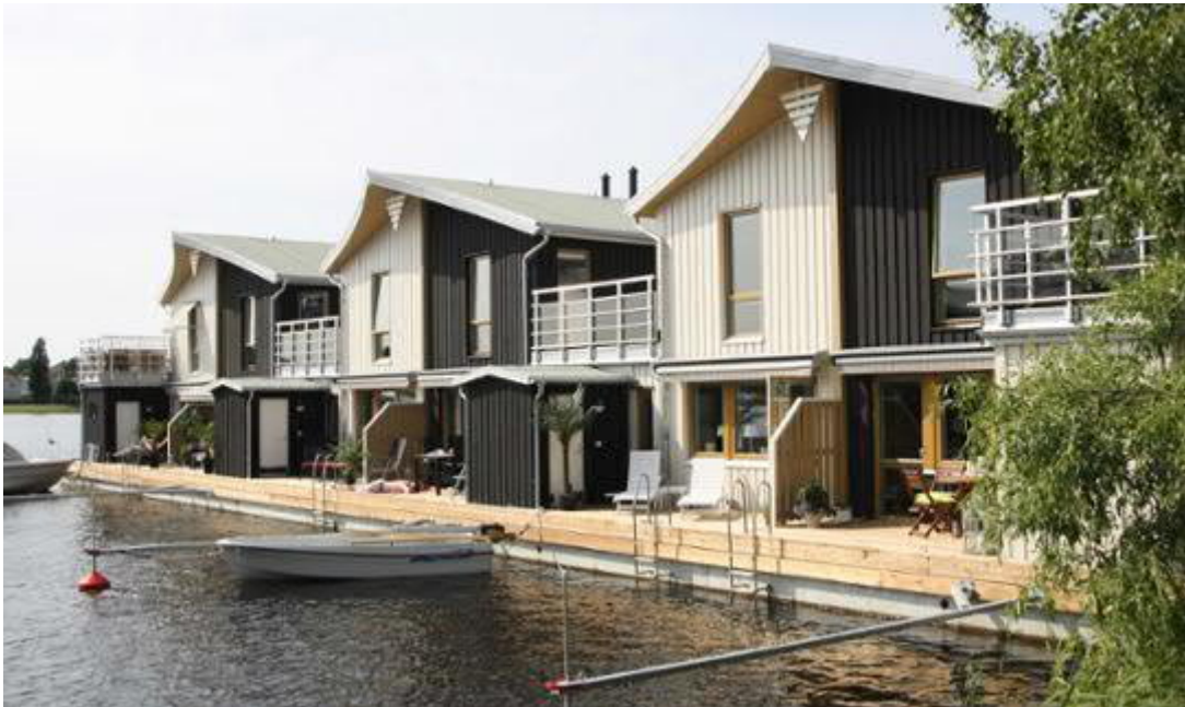
Kuva 15. Karlstadin kelluvat asunnot, joissa on hyödynnetty laajempaa ponttonikokonaisuutta yhteisesti useamman talon alla. Kuvalähde: Karlstads Bostads AB.
