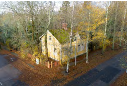
Moision Rantapuiston kohteisiin lukeutuu myös kunnostettava puutalo.
