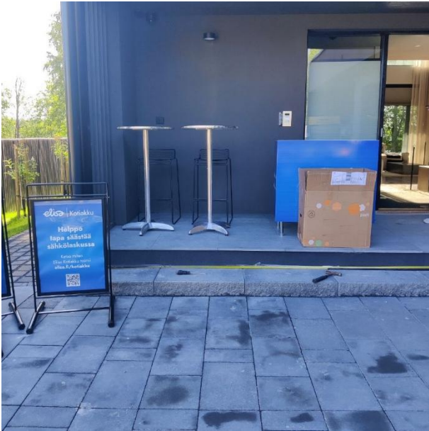
Kuva 5 Huvilainen sisäänkäynnin edusta
