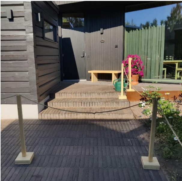
Kuva 7 Hietasaaren Veiston pääoven portaat
