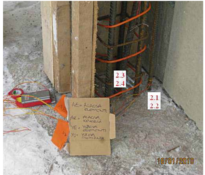
Kuva 16. Termolankojen 1.1 – 1.4 sijoitus pilasterissa
