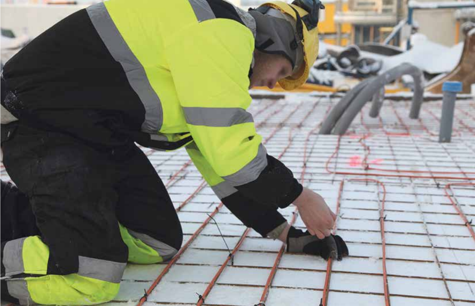
BET-lämmityskaapelin kiinnittäminen rauditusverkkoon nippusiteillä
