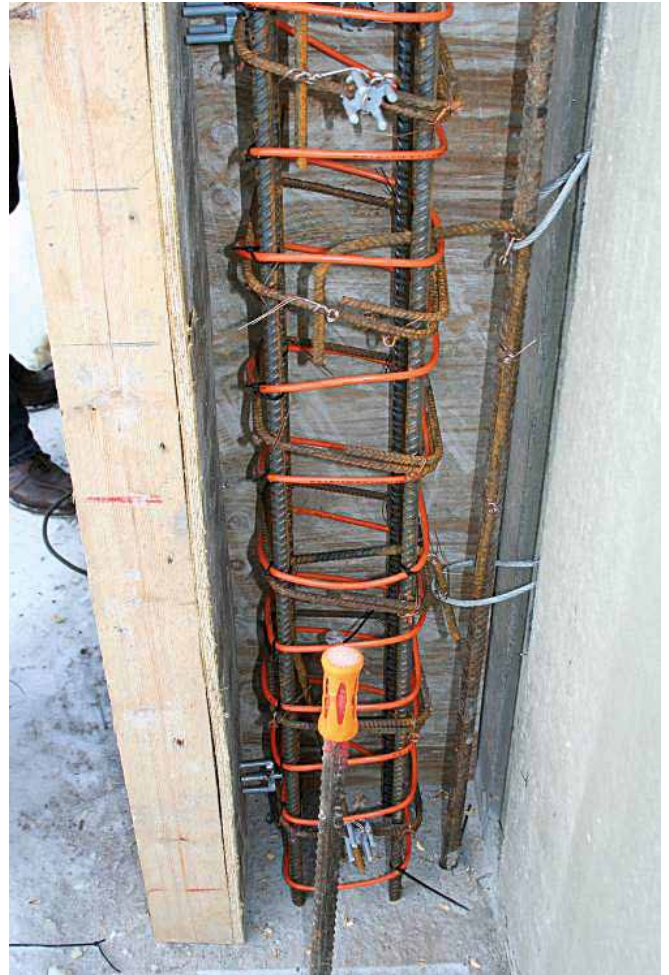
Kuva 9 Lämmityskaapeloinnin asentaminen pilariin, vaihtoehtoisesti lämmityskaapelit voidaan sijoittaa pystyyn
