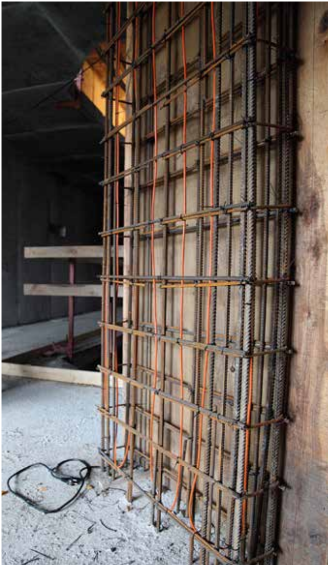
Kuva 18 Lämpölankojen sijainnit seinässä
