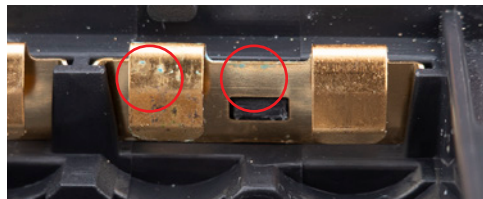
Bateriové kontakty s jasnými známkami vytekklého obsahu baterie vyžadují výměnu
