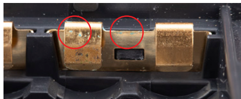
Batterikontakt med tydelige tegn på lekkasje fra batterier. Dette krever at kontakten skiftes ut.
