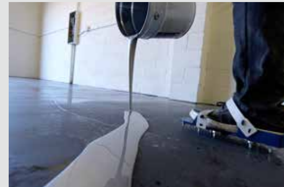
POUR ONTO FLOOR 45° DIRECTION FOR OPTIMAL PATTERN
