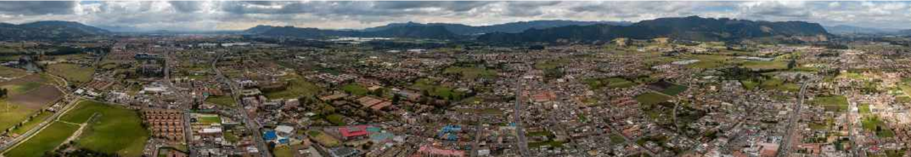
Malla vial discontinua genera enclaves disminuyendo la efectividad en la respuesta ante eventos de emergencia
