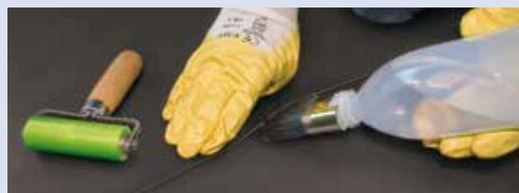
Alternativ können Flächennähte auch mit Quellschweißmittel verschweißt werden: Zwischen die mindestens 8 cm breiten Bahnüberlappungen wird das Witec Quellschweißmittel mit leicht reibenden Bewegungen des Pinsels eingebracht und der Nahtbereich anschließend mit einer Rolle angedrückt.
