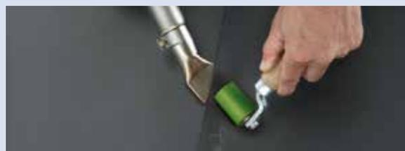
Flächennähte können mittels Heißluft (Handgerät oder Automat) verschweißt werden. Im Detailbereich wird generell mit Heißluft geschweißt, z.B. Innen- und Außenecken, T-Stöße oder Rohreinfassungen.
