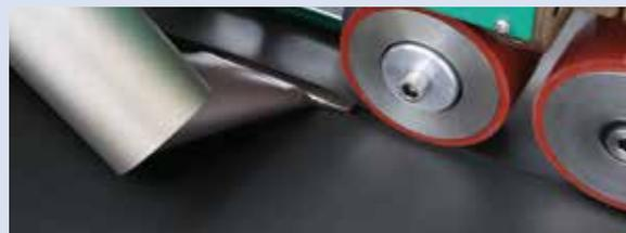
Lange Bahnnähte werden mit dem Schweißautomaten besonders gleichmäßig, sicher und rationell verschlossen.
