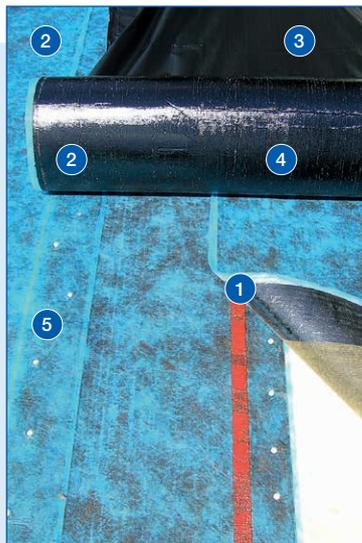
**1** Vordeckung/Trennlage: Villasub E-KV-15 SK mit Butyl – Nahtklebestreifen.
