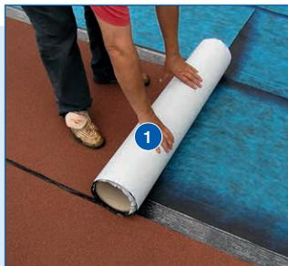
1 Die zweite Lage Villas Alpin SO wird senkrecht zur Traufe, Naht an Naht mit der Unterlagsbahn Villasub UDS E-3 verlegt. Die Bahn bis zur Hälfte ausrollen und einrichten.
