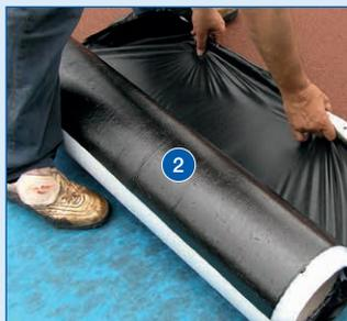
2 Die unterseitige Schutzfolie mit dem Messer trennen und zurückklappen.
