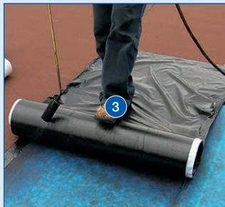
3 Die vollflächige Verklebung mit der Unterlagsbahn Villasub UDS E-3 ist durch Abflämmen des blauen Deckvlieses und thermisches Aktivieren der Klebeflächen sichergestellt.
