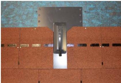
Schritt 2 : PM-Schindeln – an Elementaufbau entsprechend anpassen und Schrägschnitt gemäß Abbildung ausbilden.
