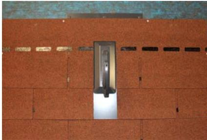
Schritt 4 : PM-Schindeln - Verlegen der weiteren Schindelreihen und hinterlaufsichere Ausbildung mit Vedatex Kaltkleber.
