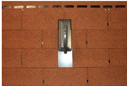
Schritt 5 : PM – Schindeln - Verlegen der weiteren Schindelreihen gemäß Abbildung
