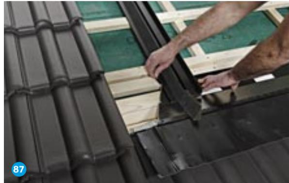
87 Das untere Eindeckblech links und rechts durch Umbiegen der Laschen an den seitlichen Eindeckblechen sichern.
