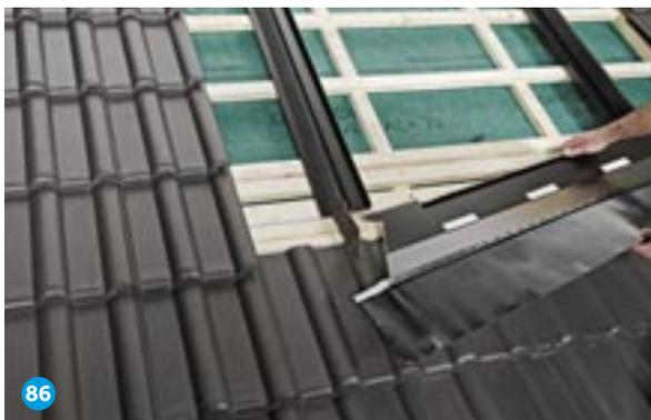
86 Vor der Montage des unteren Moduls das untere Eindeckblech einspaltig verlegen.
