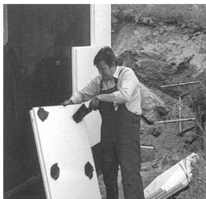
Nach Durchtrocknung der Abdichtungsschicht aufkleben der Wärmedämmplatten durch auftragen von 6 handtellergroßen Klebepunkten (oder vollflächig mit Zahnschpachtel).
