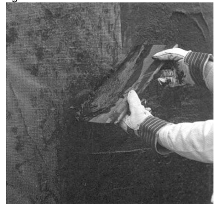
2. Beschichtung Villafalt 2K unverdünnt mit Spachtel in einer Schichtdicke von mind. 3 mm aufziehen. Verbrauch: mind. 3,5 - 4,5 kg/m 2
