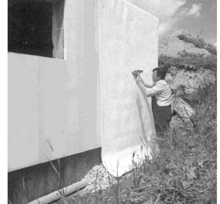
Schutz durch Anbringung einer Wärmedämmung und Schutzvlies.
