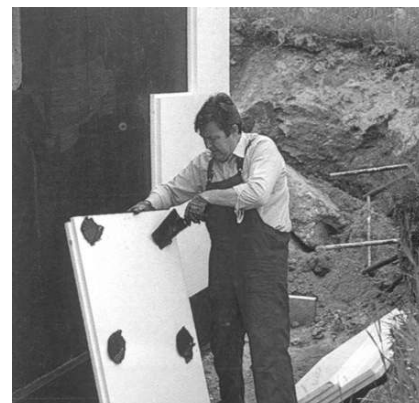
Nach Durchtrocknung der Abdichtungsschicht aufkleben der Wärmedämmplatten durch auftragen von 6 handtellergroßen Klebepunkten (oder vollflächig mit Zahnschpachtel). Verbrauch: ca. 1,5 bis 2,5 kg/m 2 .
