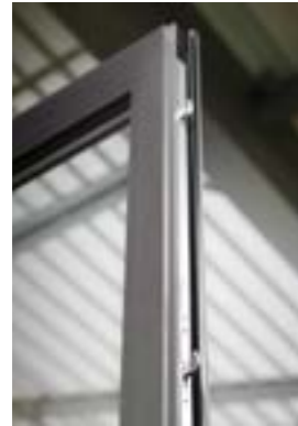
Points de verrouillage avec têtère inox
