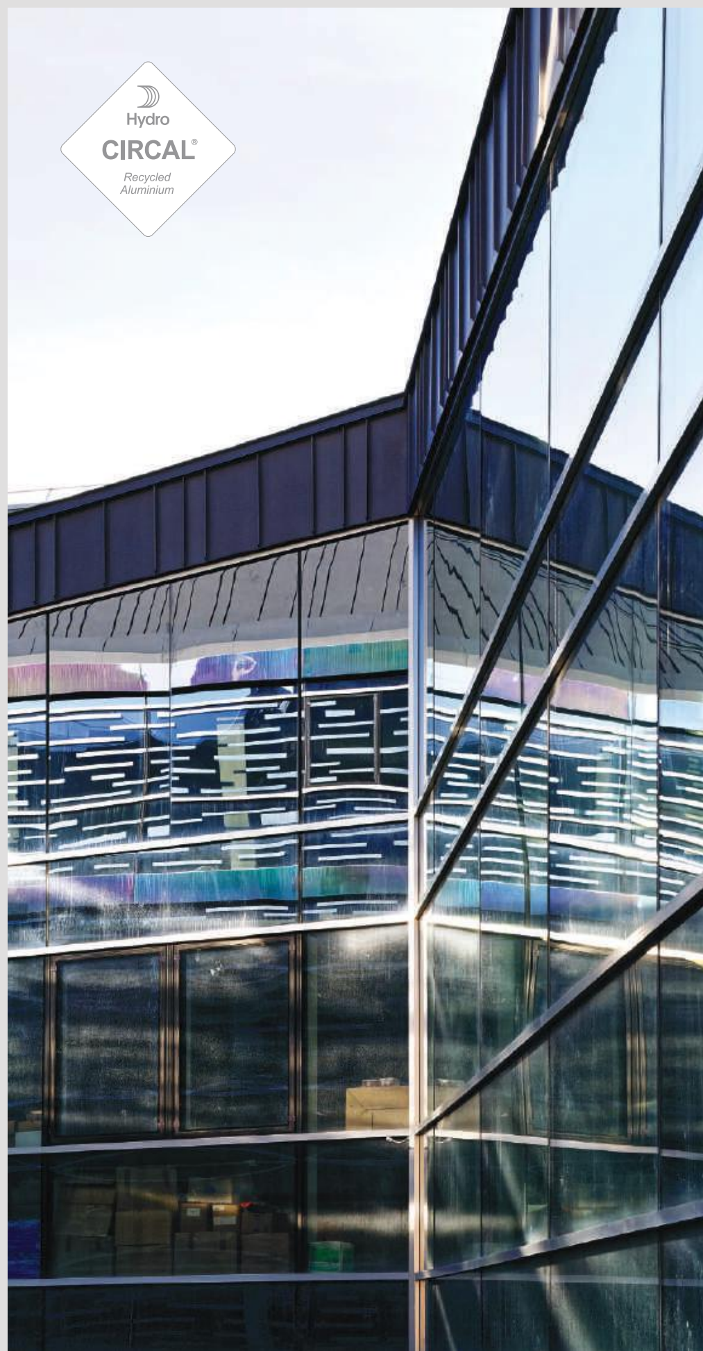
IESEG, Lille (59) - Architecte : Trace - Entreprise : Olivier - Photo : ©Franck Deletang
