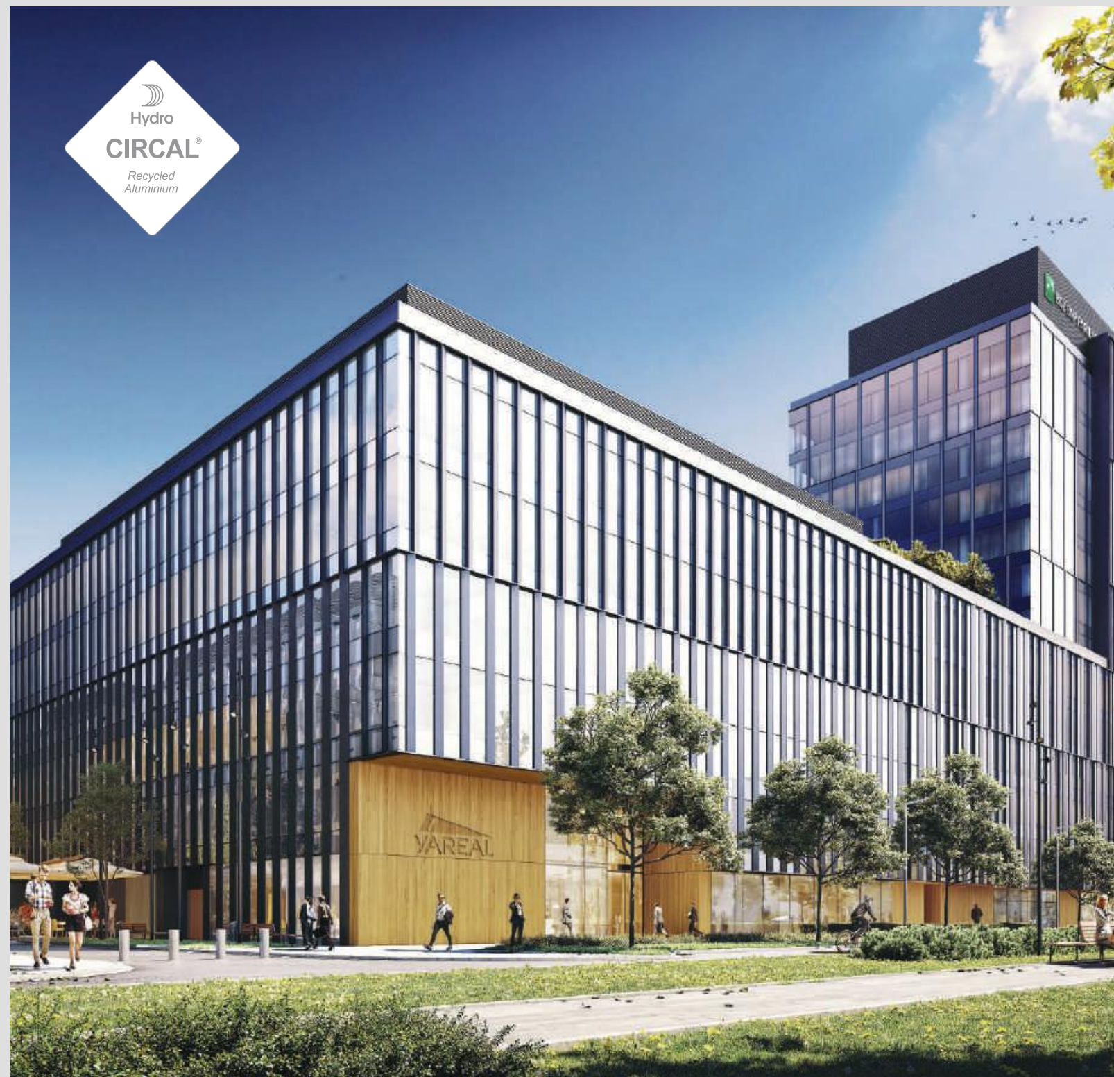
Maître d'ouvrage : Porr - Architecte : HRA Architects - Entreprise : Firma Widok Sp. z o. o. - Photo : ©HRA Architects
